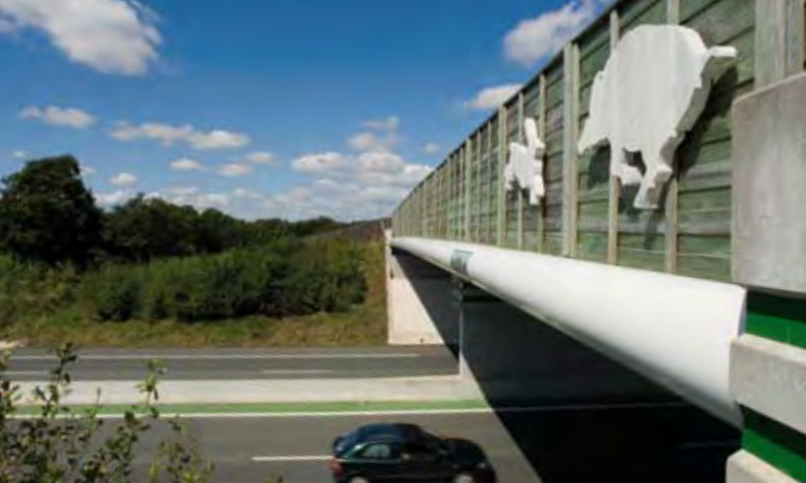
Exemple d'éco-duc enjambeant une autoroute (source ASF).
