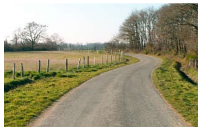
Des profils de voies «simples» (fossés, banquette enherbée, pas de bordures béton, pas de trottoirs).
