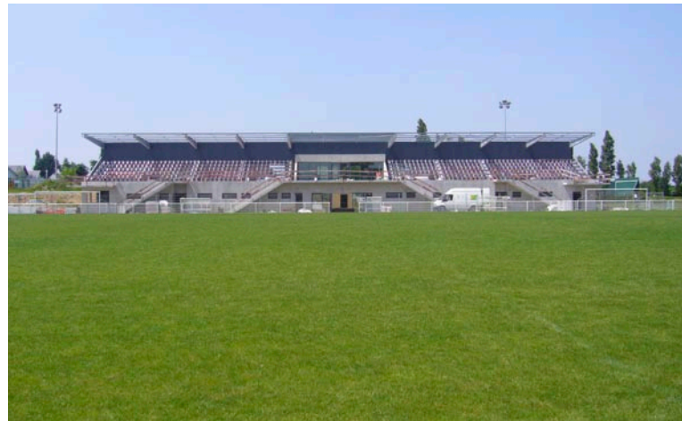
Les tribunes en cours de chantier
