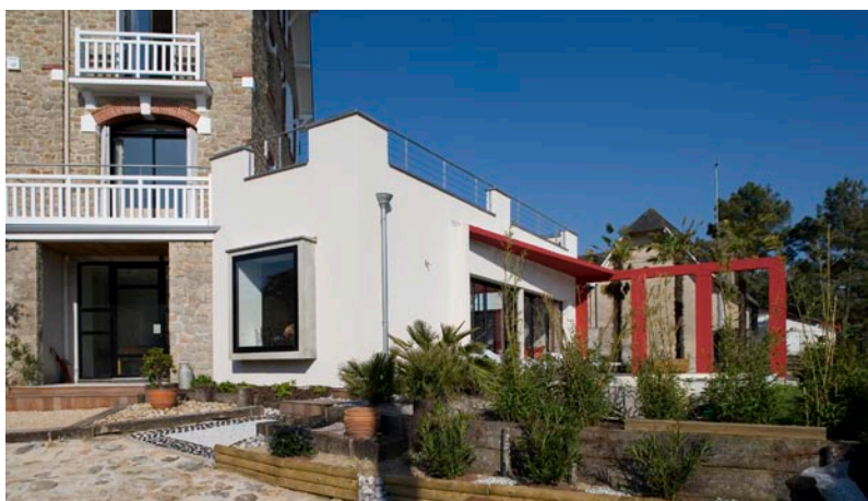
Liaison de la maison avec l'extension
