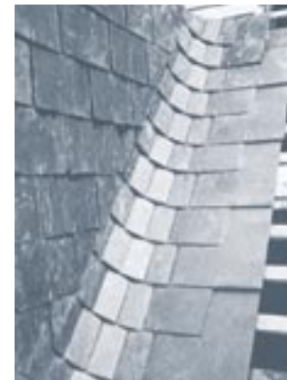
Noue en ardoise.
