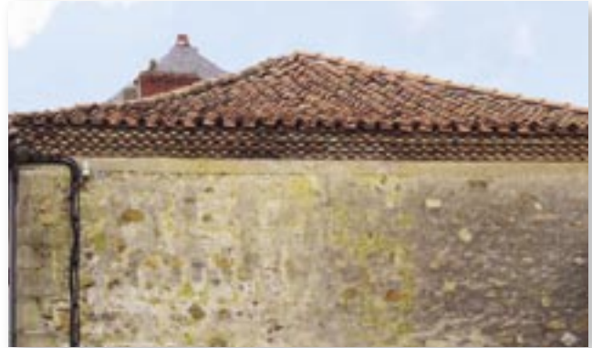
Toiture à croupes couverte en tuiles canal.
