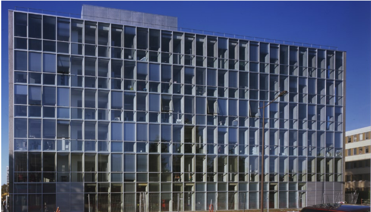
Mur-rideau Façade Ouest/Sud-Ouest
