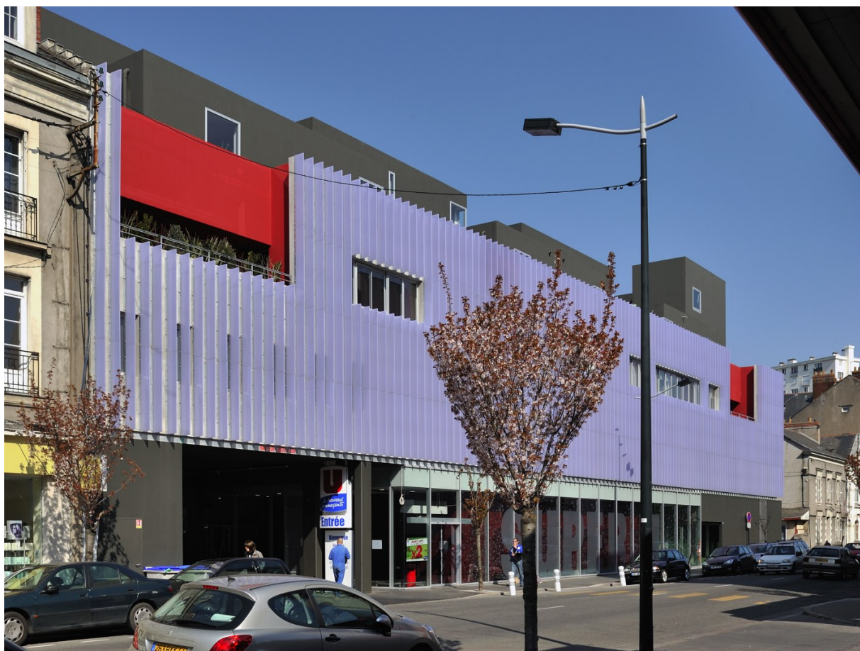
Façade rue Dalby
