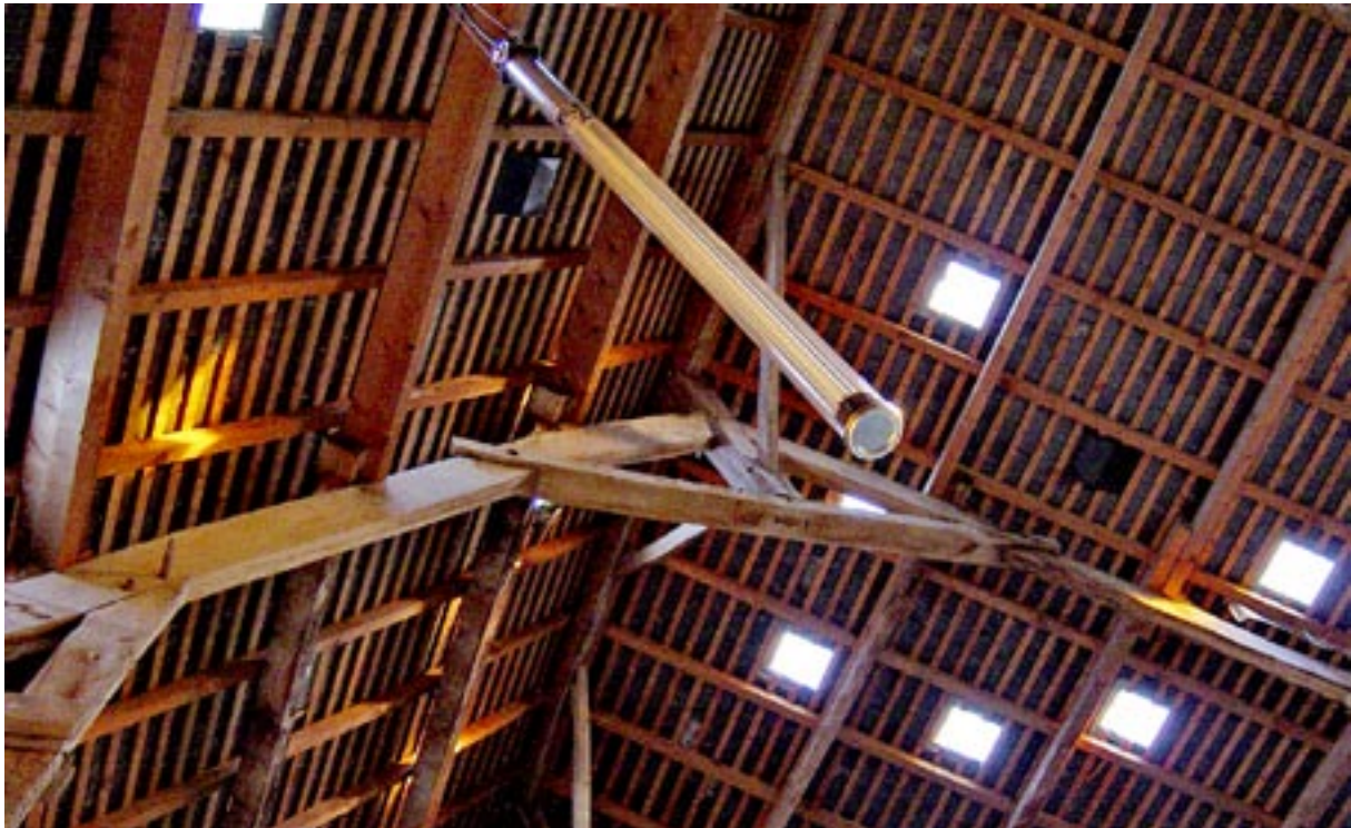
Les anciennes ardoises manquantes ont été remplacées par des petits vitrages qui ponctuent l'ensemble de la toiture de manière aléatoire. Ces percées laissent entrer le soleil par fines lamelles et baignent tous les espaces semi-intérieurs de lumières tamisées.
