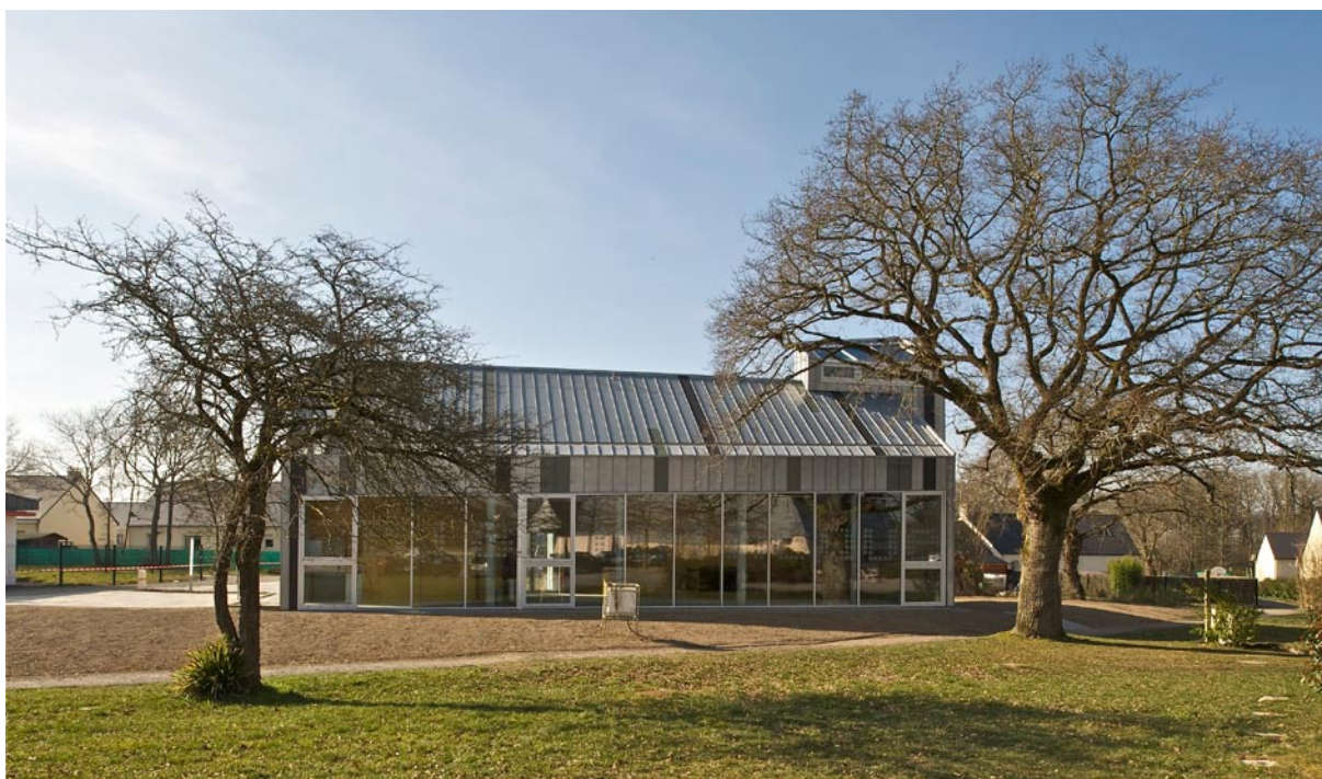
Vue de la façade Nord
